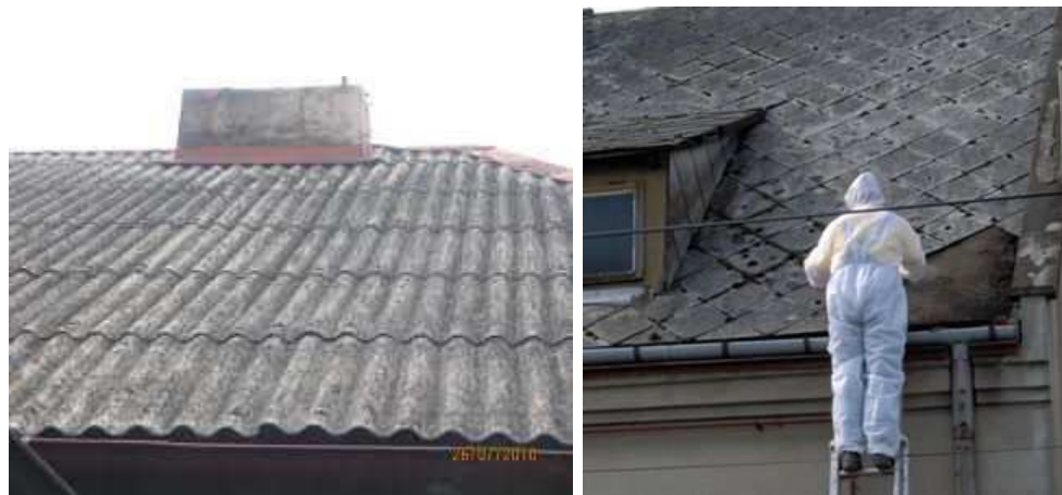
Rycina 20. Rodzaje wyrobów zawierających azbest. Po lewej - płyty dachowe faliste (W02), po prawej - płyty azbestowo - cementowe typu „karo” (W01)
