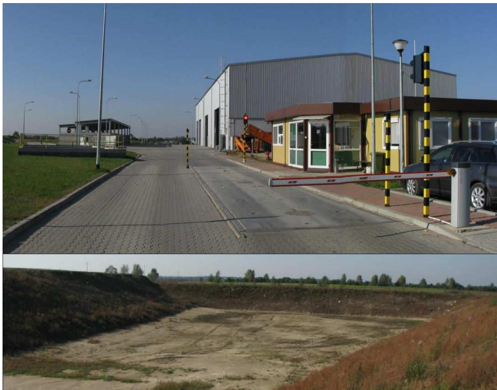
Kwatera odpadów azbestowych (w budowie)
