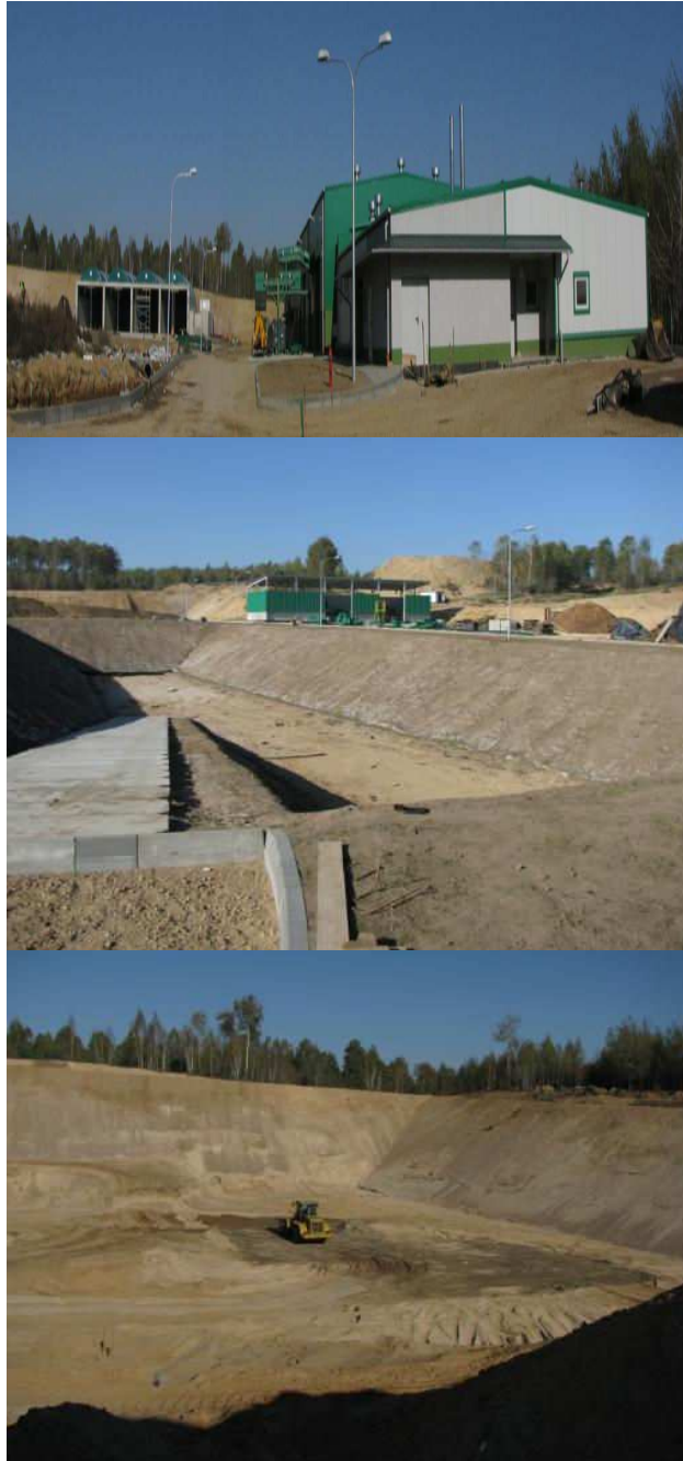
Katery odpadów azbestowych (w budowie)
