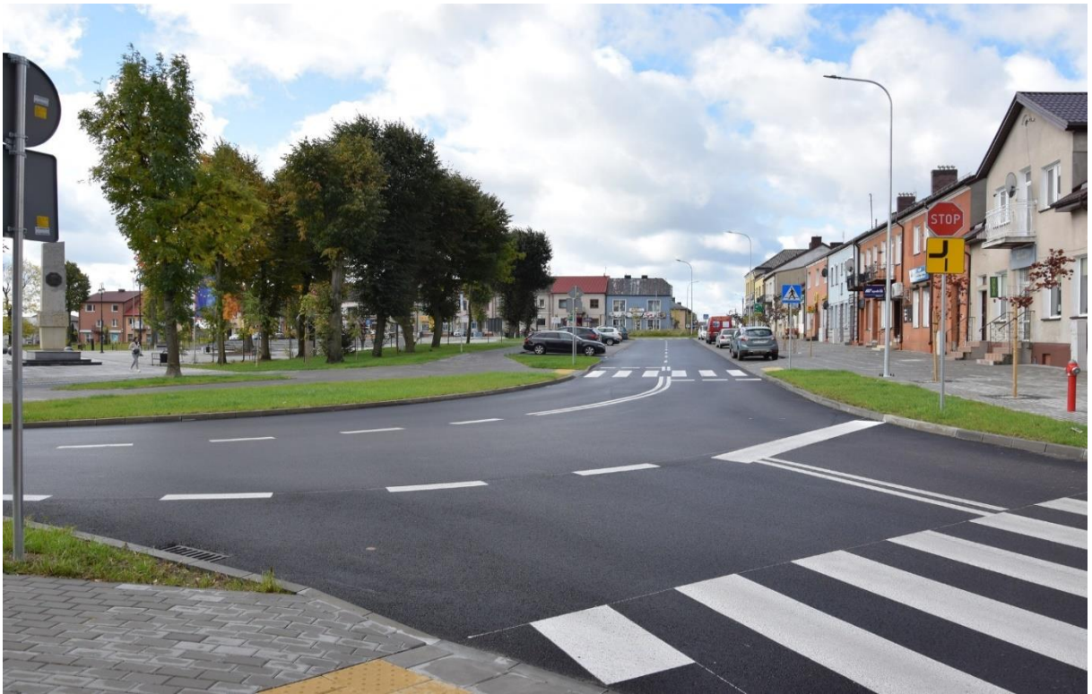
Nowo przebudowana ul. Plac Wolności
