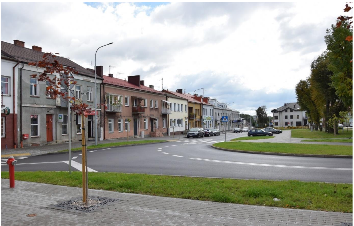
Nowo przebudowana ul. Plac Wolności
