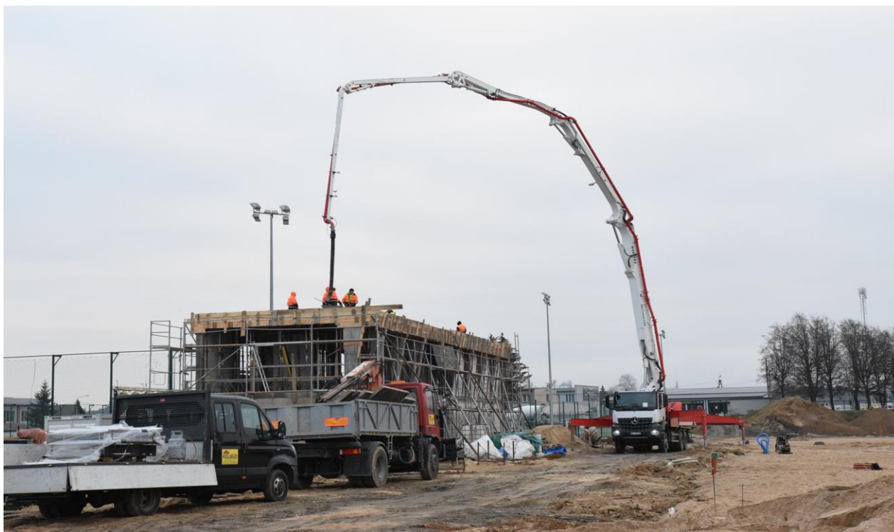
Prace przebudowy stadionu miejskiego
