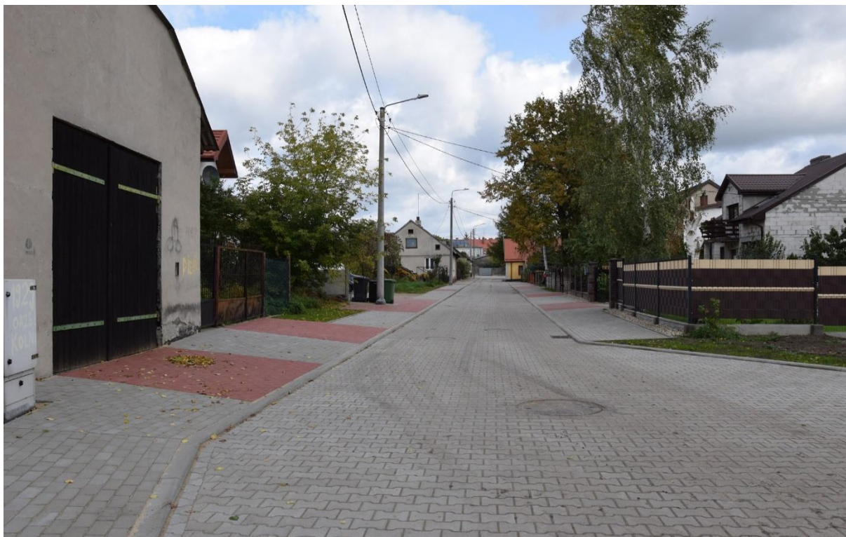
Ulica Łazienna po remoncie
